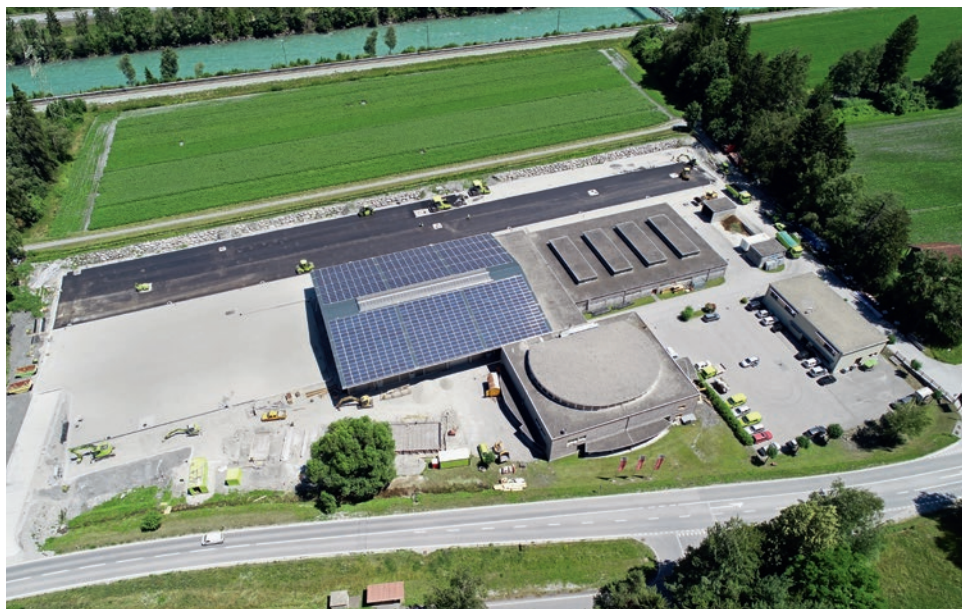
Bauarbeiten ASTRA, Rückhalte- und Warteraum Bündner Arena.
