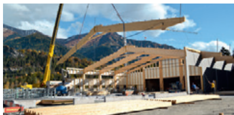
Aufrichten der Dachkonstruktion im Oktober.
